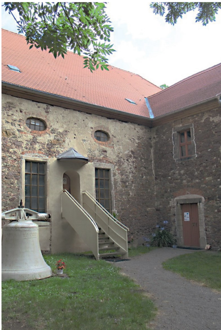
Der nächste Sanierungsfall ist das Kirchenschiff.
