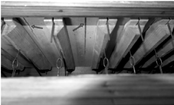
Die Kanzellenrisse innerhalb des Windkastens führen zu starken Heulern.
