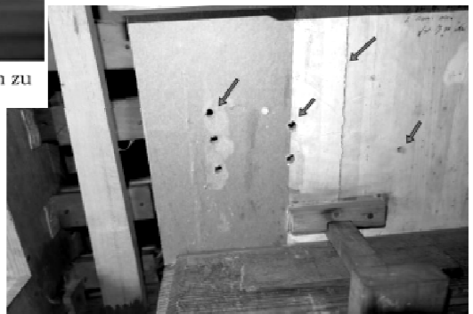
Um die Heuler zu beseitigen wurden die Windladen nicht repariert, sondern mehrere Entlastungslöcher in die Kanzellenspunde gebohrt.
